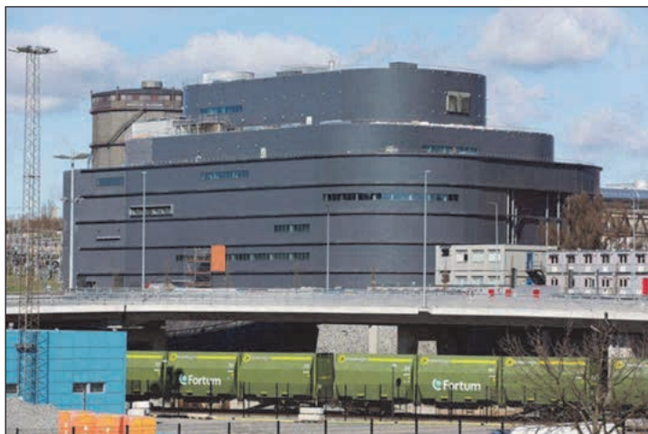
Рис. 7.24. ТЕЦ Värtaverket в м. Стокгольм, Швеція ( https://www3.fortum.com/about-us/our-company/our-energyproduction/our-power-plants/vartaverket-chp-plant )
