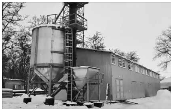
Рис. 11.14. Модульні котельні на гранулах: а – компонування модульної котельні ( http://www.biowatt.com.ua/ ); б – модульна котельня компанії PPEngieniring ( https://c-energy.com.ua/g5649655-modulnye-kotelnye )
